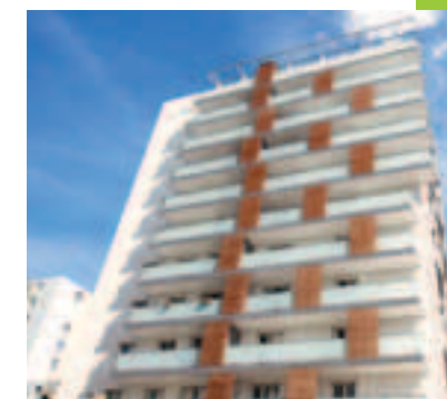
Rénovation ANRU, Esplanade Paul Cézanne à Reims Architecte : Thienot-Ballan
