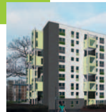
Remise en état immeuble - bld Vasco de Gama à Reims Architecte : Alain Motto
