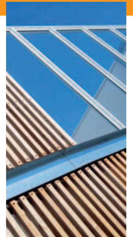
Maisons individuelles locatives - Avenue de Bruxelles, Champ aux Ecus à Fagnières - Architecte : Cabinet Fouquerey Jacquet
