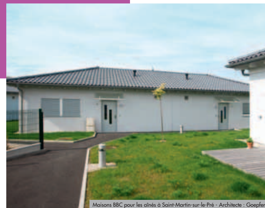
Maisons BBC pour les aînés à Saint-Martin-sur-le-Pré - Architecte : Goeppfert
