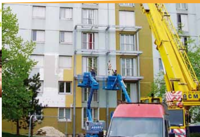
Rénovation du quartier Croix du Sud, à Reims : pose des balcons.
