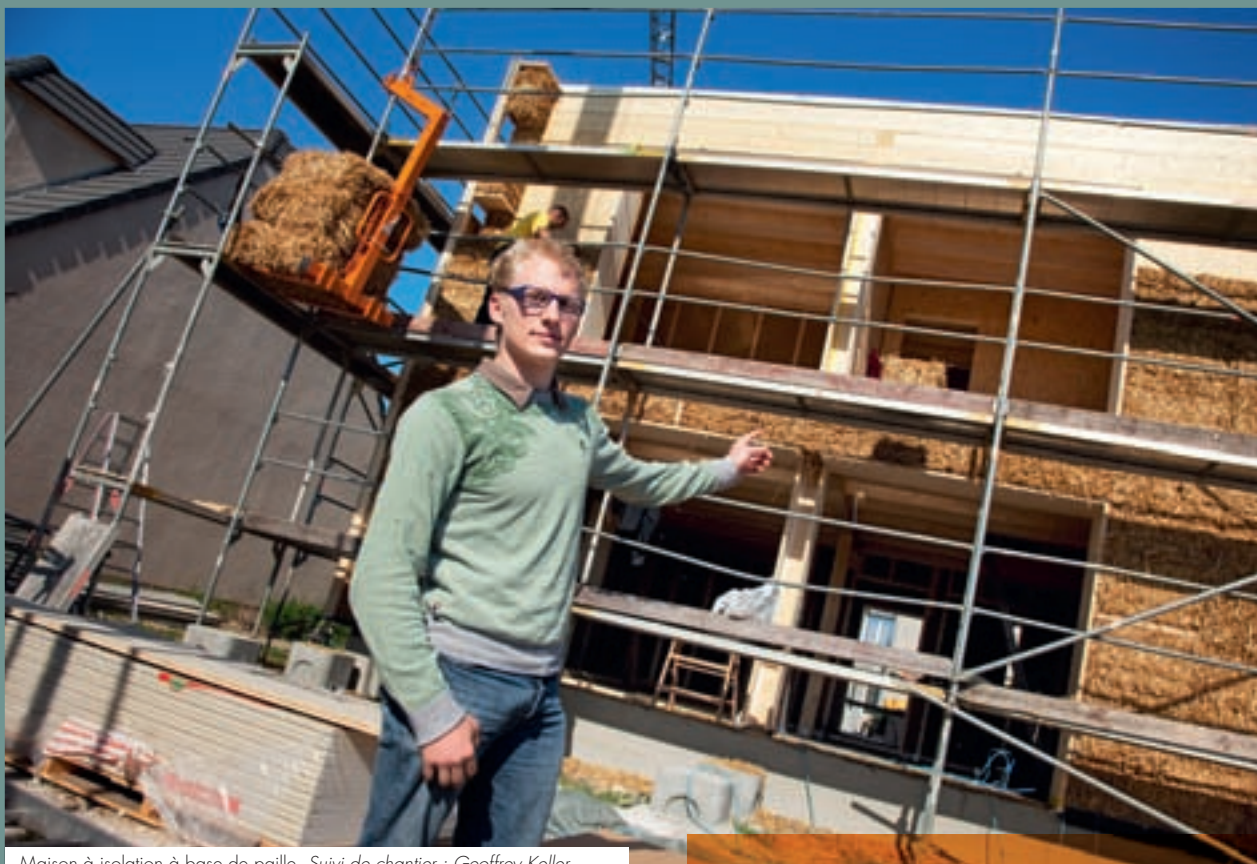
Maison à isolation à base de paille. Suivi de chantier : Geoffrey Keller.
