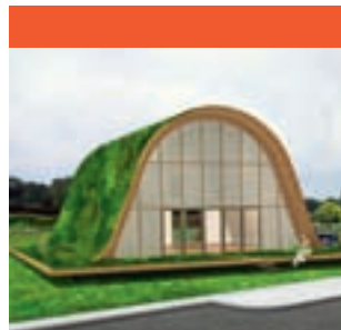
Maison vague à Sillery. Architecte : Patrick Nadeau. Suivi de chantier SOCREL : Benoît LABOUROT.
