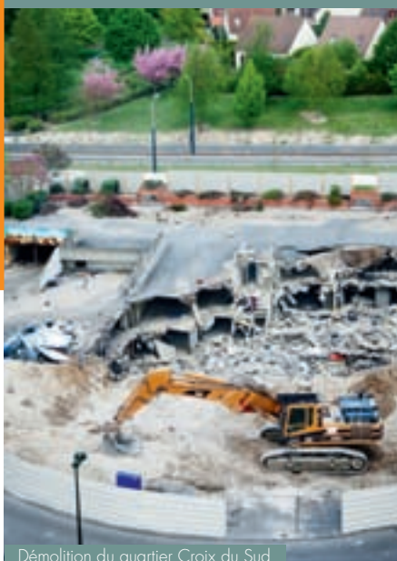
Démolition du quartier Croix du Sud
