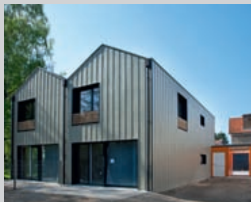
Maisons en bois à Warmeriville. Architecte : Jean-Philippe Thomas Suivi de chantier SOCREL : Sandra Moutiers
