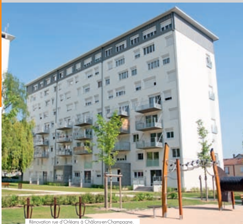
Rénovation rue d'Orléans à Châlons-en-Champagne.
